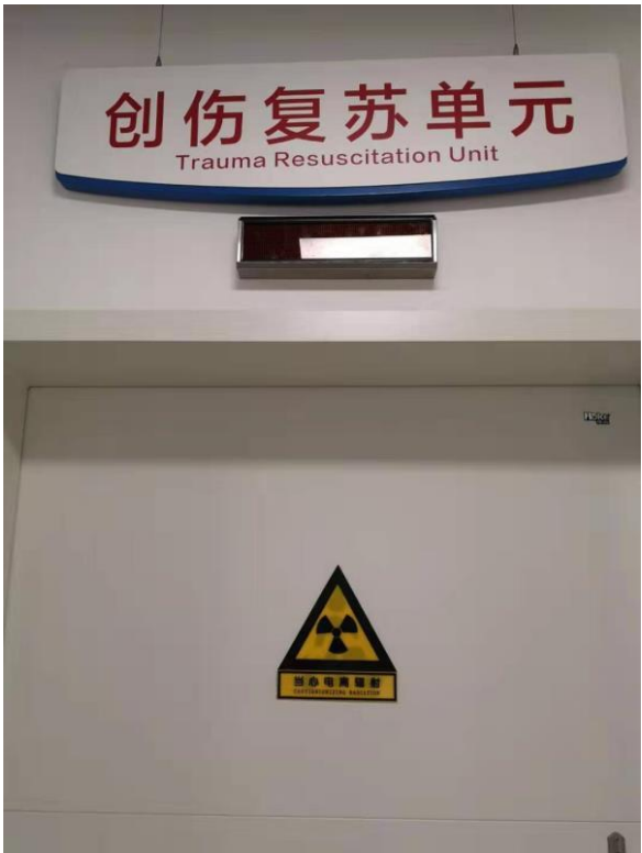
图 4-1 机房门外电离辐射警示与工作状态指示灯
